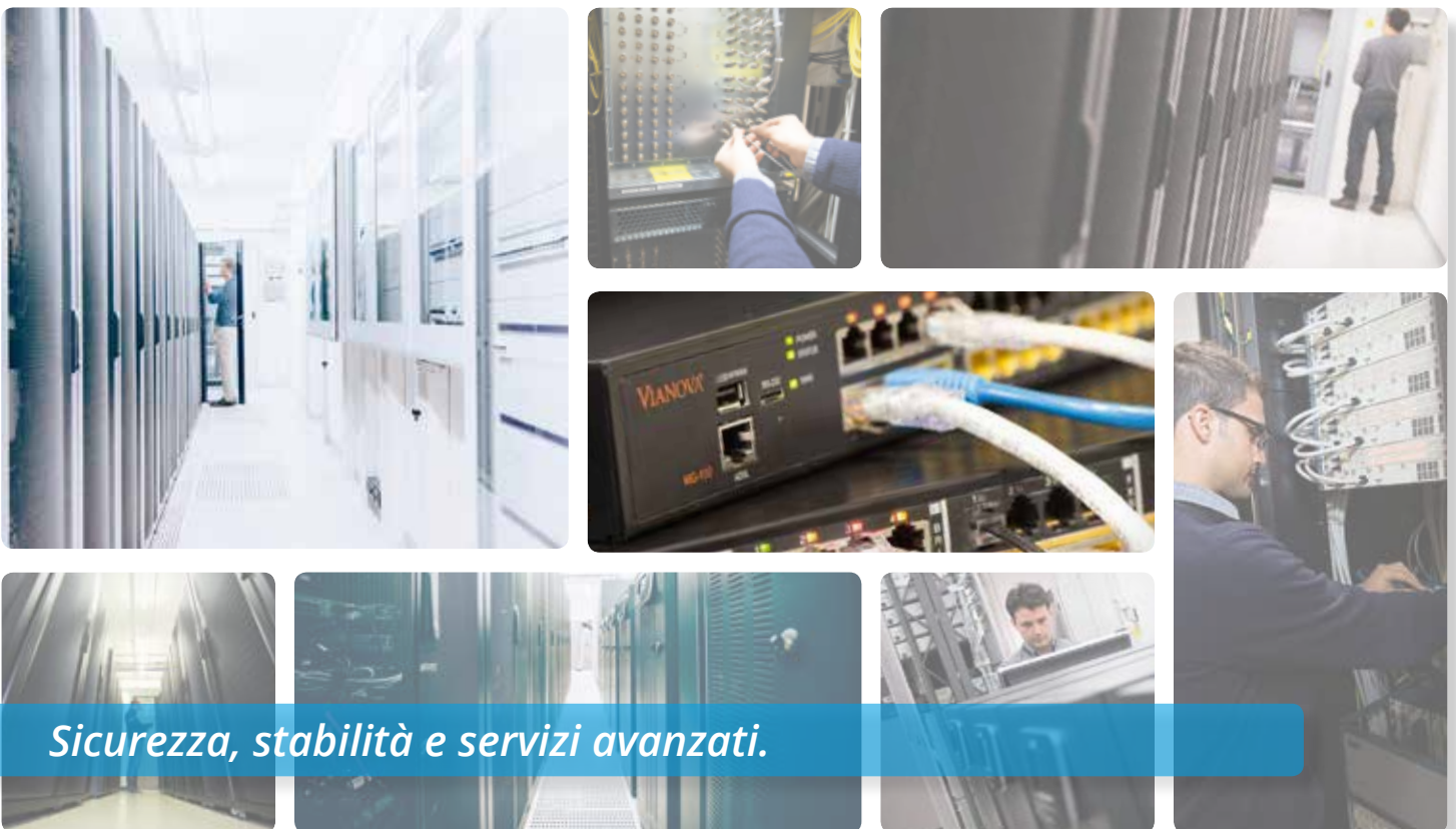
Data Center di Massarosa (LU)
