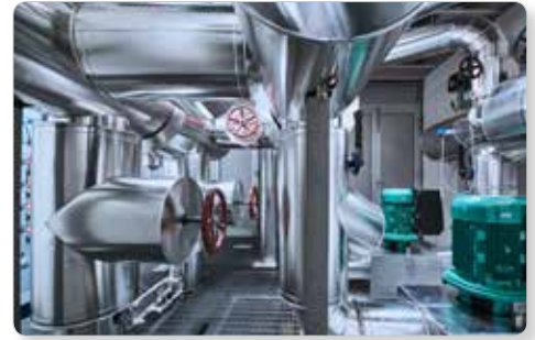
Pompe di raffreddamento
