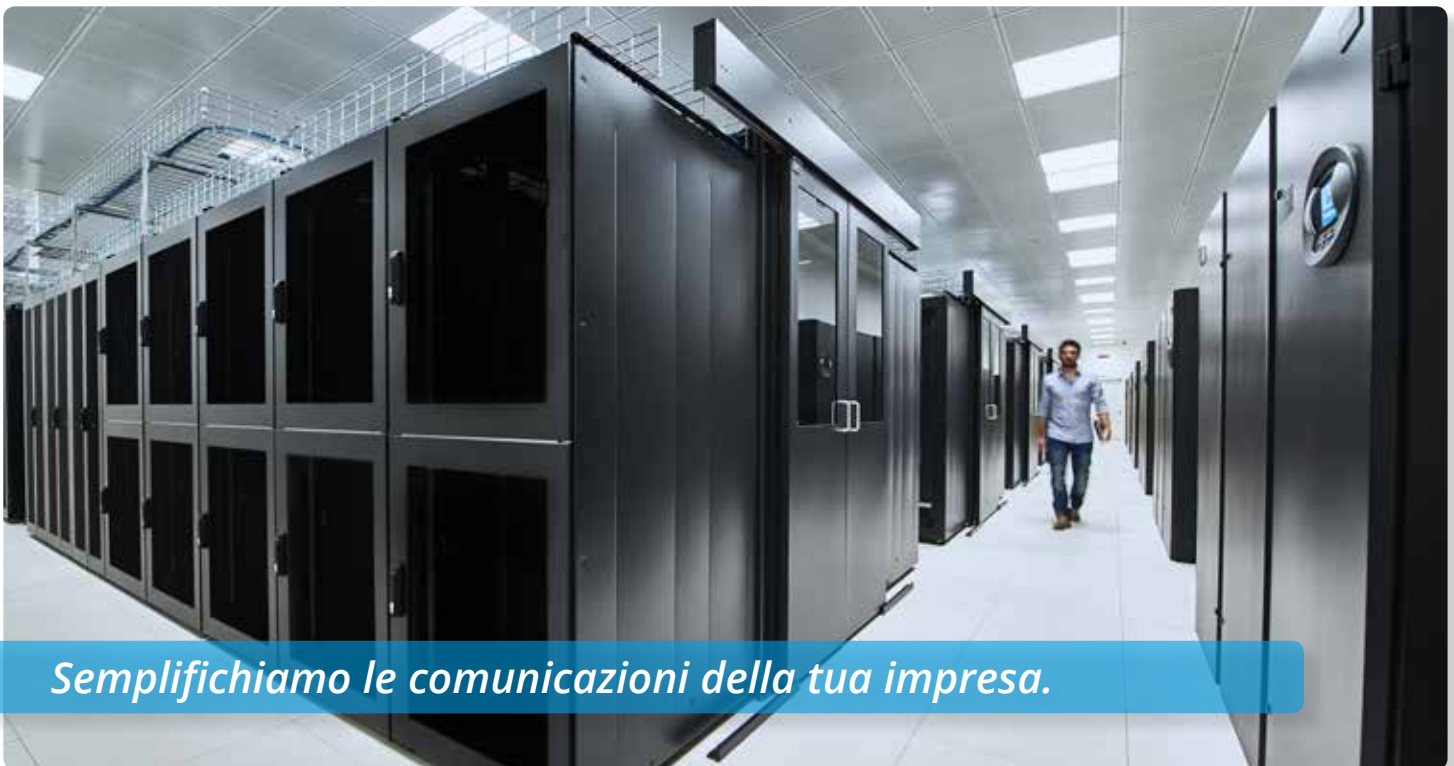
Welcome Italia, Data Center di Montacchiello (PI)
