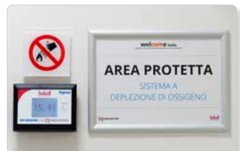
Sistema antincendio a riduzione di ossigeno
